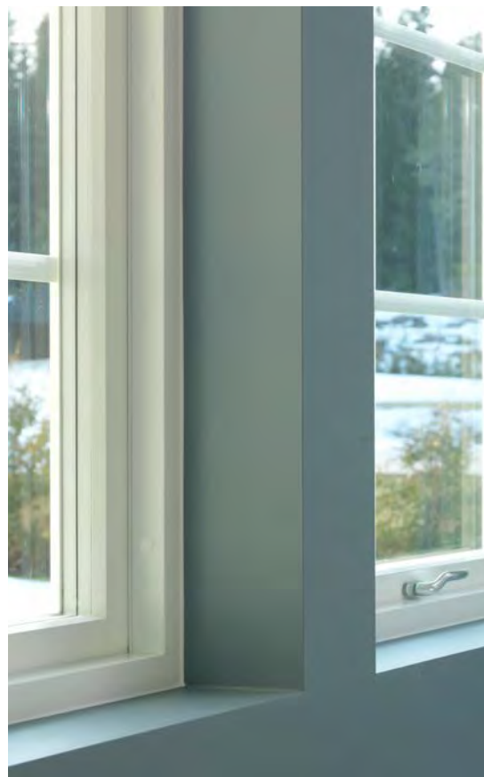
+ Listefrie vinduer og balkongdør
